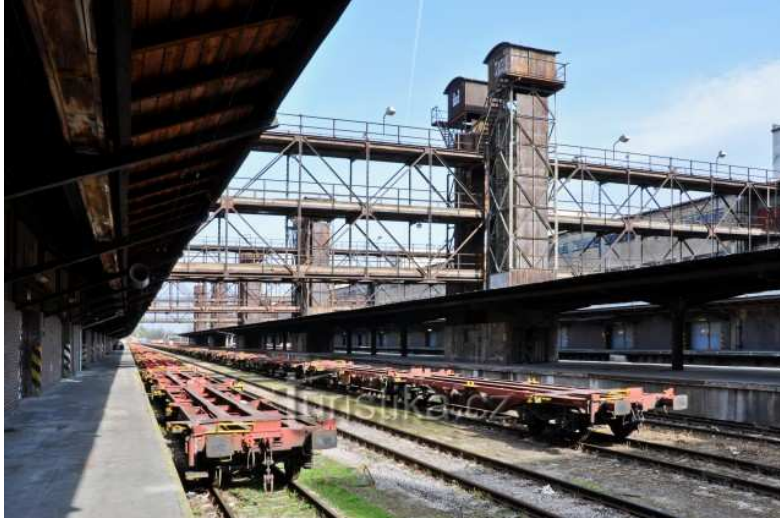
Pražská nádraží_NÁKLADOVÉ NÁDRAŽÍ ŽIŽKOV_FOTO JAN ZIKMUND
