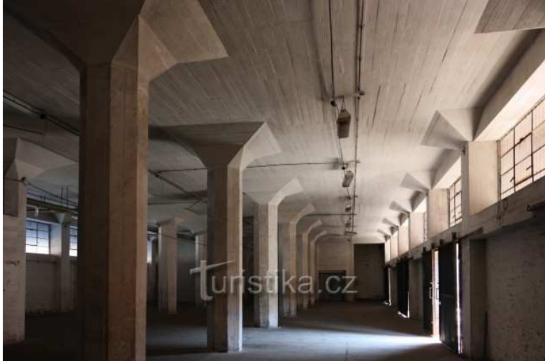
Pražská nádraží_NÁKLADOVÉ NÁDRAŽÍ ŽIŽKOV_FOTO LUKÁŠ BERAN
