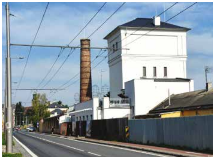
ZREKONSTRUOVANÁ VODÁRENSKÁ VĚŽ RECONSTRUCTED WATER TOWER
